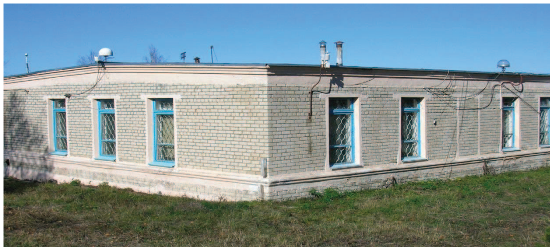
Рис.1. Антенны и метеодатчики станции ARTU. Расположены на крыше устойчивого кирпичного одноэтажного здания с открытым небосводом. GPS-антенна справа, ГЛОНАСС - слева
