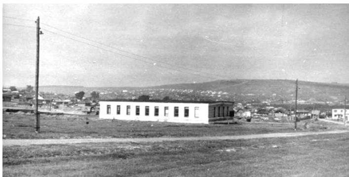
Рис.1 В правой части здания: одно окно сбоку и 4-е окна с торца расположена с/ст "Арти"
